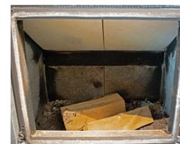
Placez 2 blocs de bois plus petits en croix par-dessus. Ne placez les blocs l'un contre l'autre afin que l'air de combustion puisse bien circuler autour du bois. Ne placez pas les bûches complètement contre la paroi arrière afin qu'une quantité suffisante d'air puisse encore pénétrer dans la chambre de combustion par les entrées d'air arrière.
